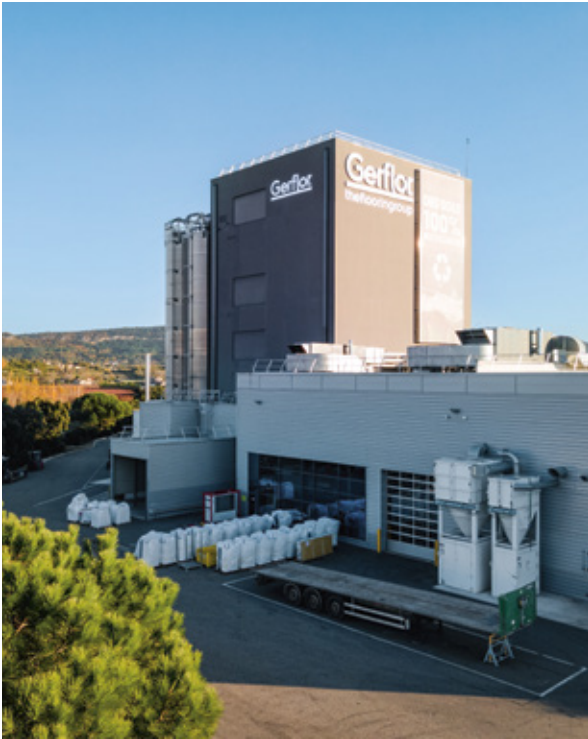
↑ Usine Dalles et Lames, Saint-Paul-Trois-Châteaux, France.
